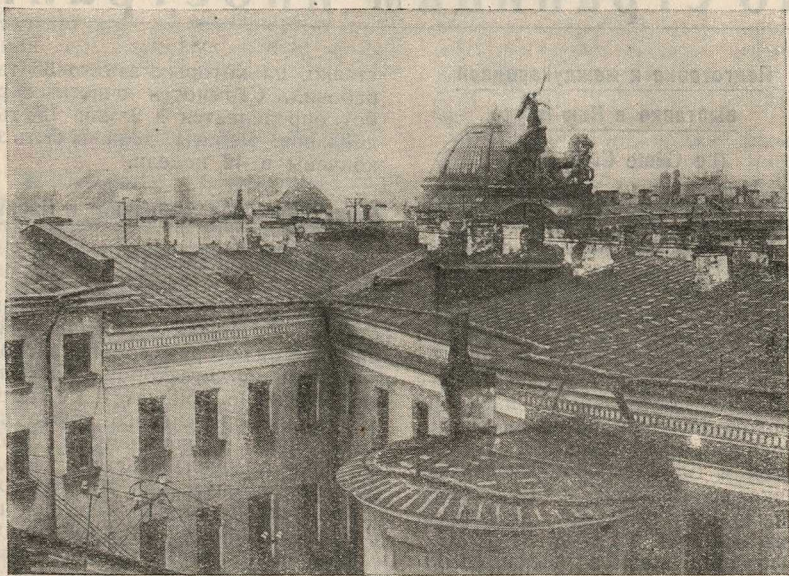
Ремонт крыши мастикой „Коррозит № 2“ (Ленинград)
