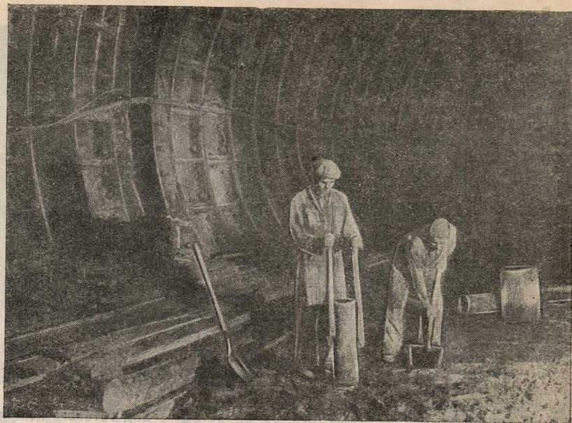
Укладка бетонного основания под рельсы на строительстве Горьковского радиуса метро
