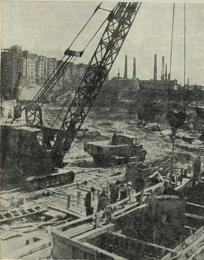
На стройке Дворца Советов. Бетонировка внешнего кольца
