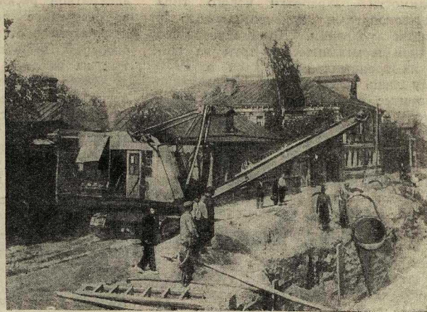
Опускание труб экскаватором „Копель“
