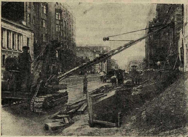
Засыпка траншей канавозасыпателем
