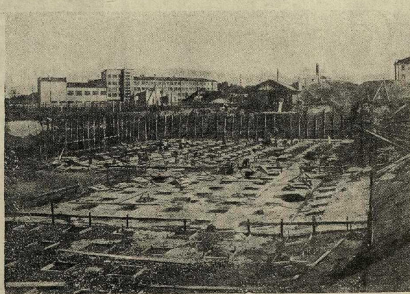
Краснопресненская водопроводная станция. Бетонные работы на резервуаре чистой воды
