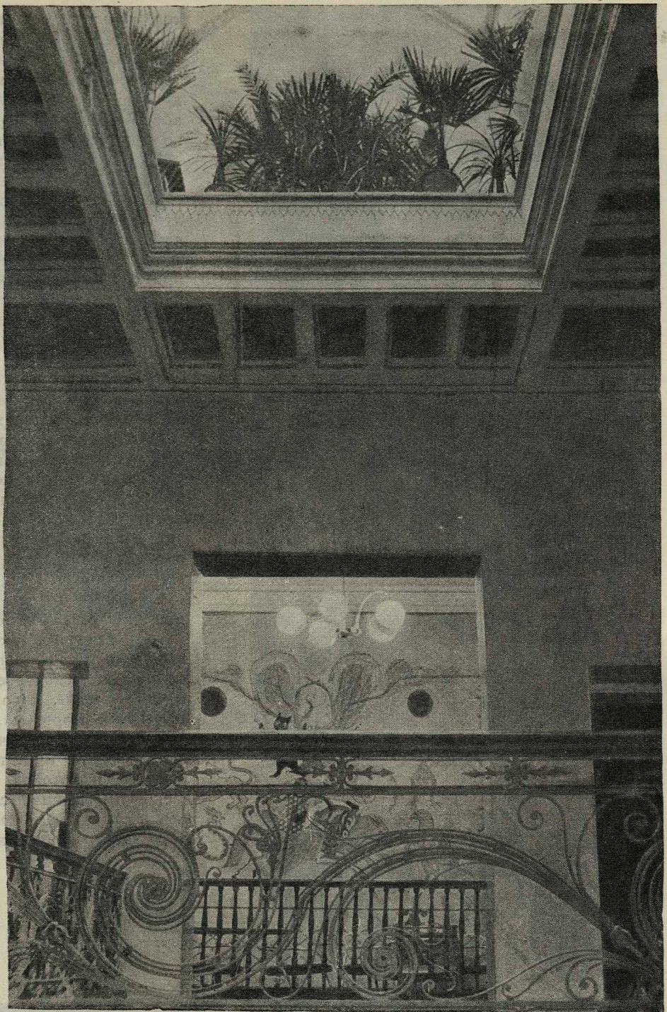
Лестничная площадка и потолок 3 этажа главного корпуса. Автор арх. А. В. Власов
