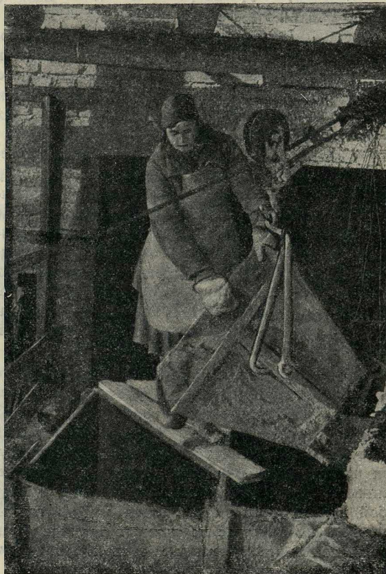
Выгрузка раствора в приемный бункер
