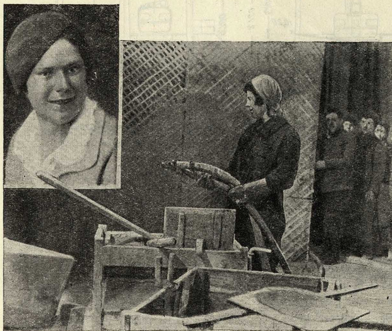
Оператор машино-штукатурной конторы Моссовета тов. Антонова на собрании штукатуров демонстрирует работу раствора-насоса
