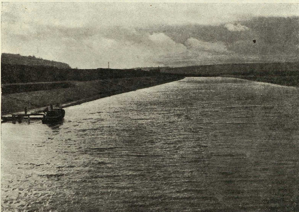
Канал Москва-Волга. Законченный сооружением опытный участок канала
