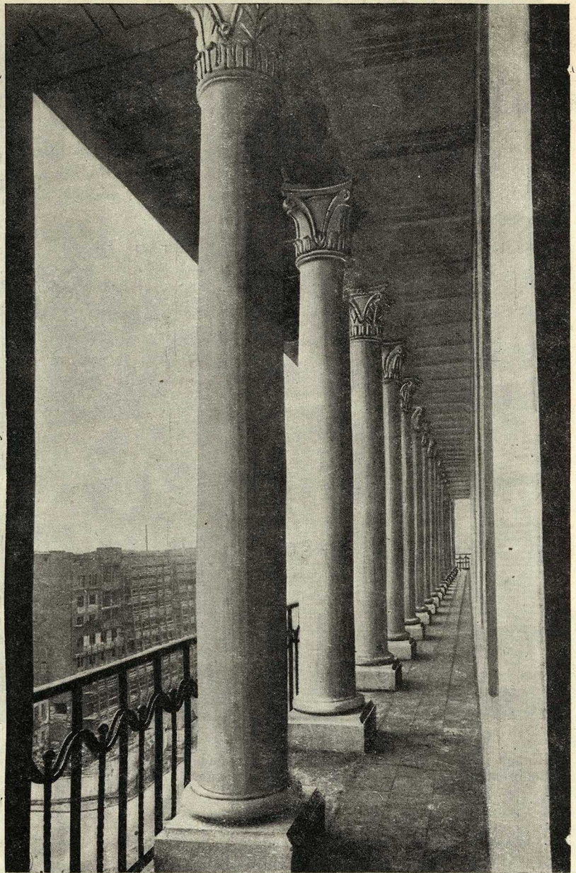
Жилой дом ИТР. Земляной вал. Колоннада 9 этажа. Автор проекта арх. И. З. Вайнштейн.
