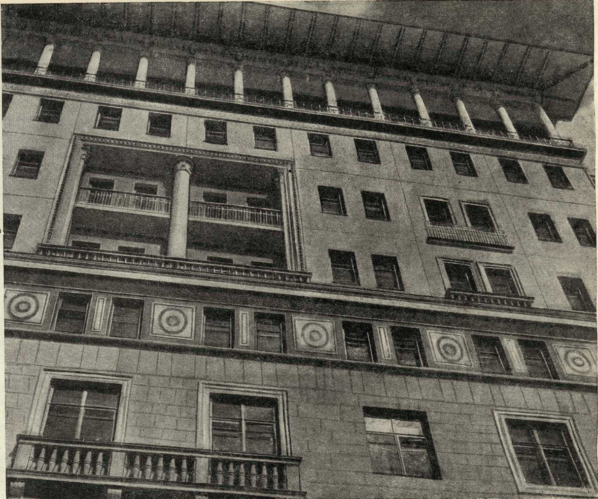
Жилой дом ИТР. Земляной вал. Деталь фасада Выстроен по проекту арх. И. З. Вайнштейна.
