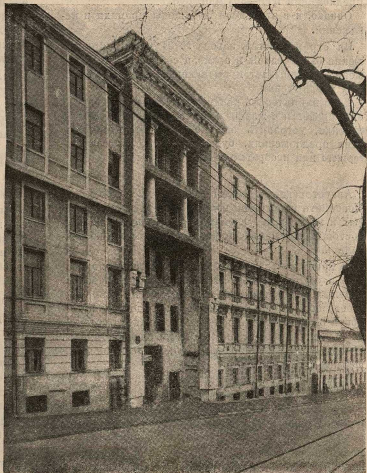
Надстройка 2 этажей. Лубянский пр. № 21 Центральная часть оформлена двумя коринфскими колоннами. Колонны дважды бессмысленны—во-первых они не столько несут, сколько висят в воздухе (зрительно воспринимаются как неконструктивное решение) и во-вторых—ордер хотя и присутствует, но он уничтожен, он перечеркнут пополам толстой плитой балкона. Пример чрезвычайно непродуктивного и халтурного решения.
