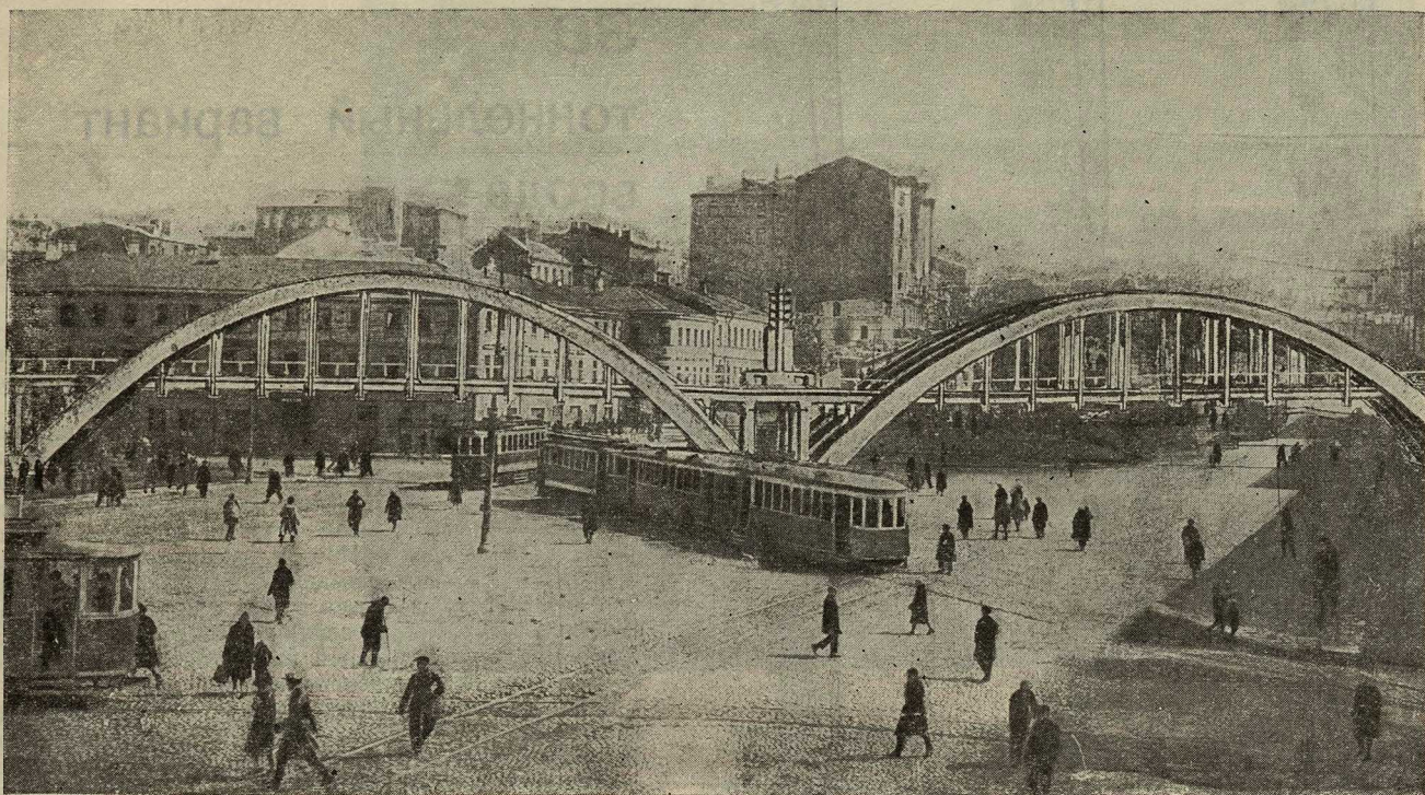
Пересечение глубоким вводом Трубной площади (по варианту ввода № 1) Два железобетонных арки пролетом 45 метров
