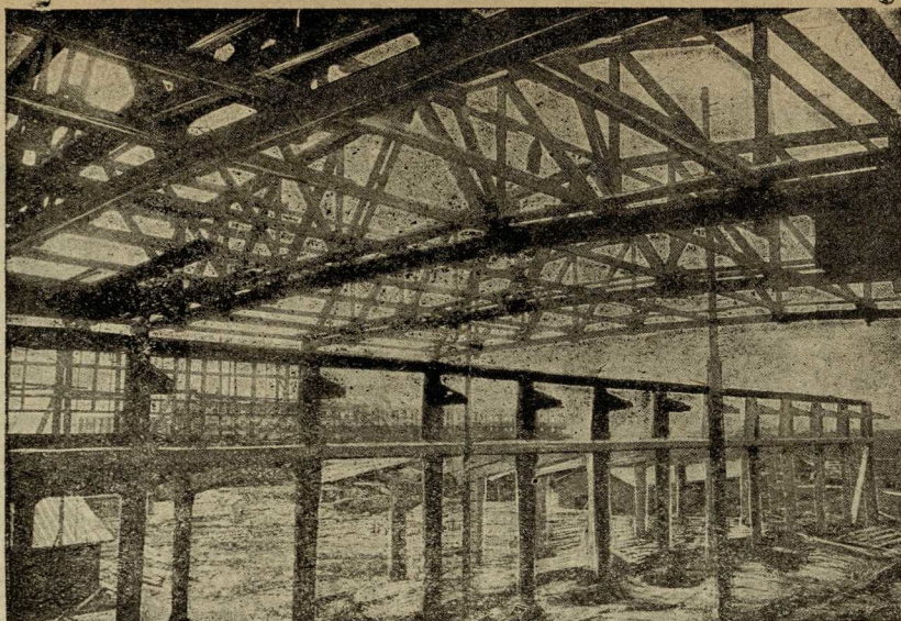
Установка ферм на сернокислотном заводе
