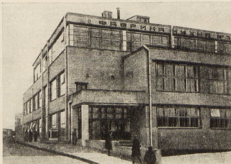
Фабрика-кухня № 3. Бужениновка. Общий вид. Арх. С. Нурабцев
