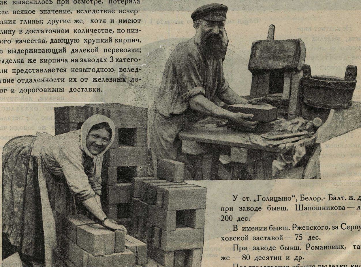
Формирование кирпича-сырца ручным способом.
