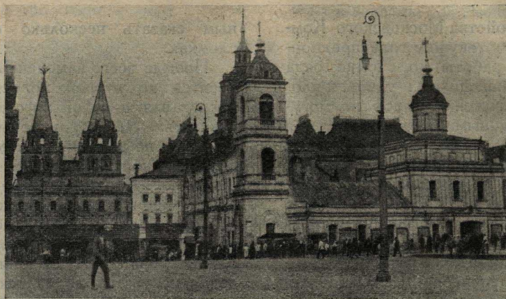
Казанский собор и Воскресенские ворота. Колокольня позднейшей архитектуры намечена к сломке. На самом соборе будут восстановлены сохранившиеся под штукатуркой прежние формы.
