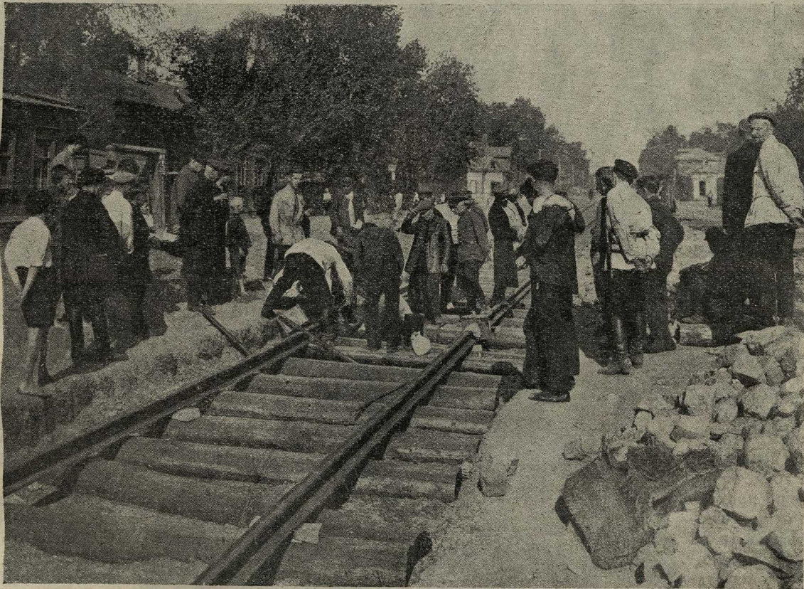
Измайловская линия. Укладка рельс со сваркой стыков термитом.
