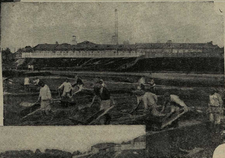
Прокладка дренажных труб по Вельяминовской улице, по которым почвенные воды будут стекать в водосток и впадать в Хапиловск. пруд.
