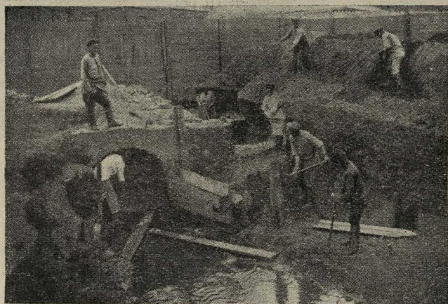
Рис. 1: Замена досчатого настила торцовой шашкой на Б. Краснохолмском мосту. Рис. 2: Устройство нового железобетонного моста через Андреевский ручей по Варшавскому шоссе и прокладка рельс для трамвая. Рис. 3: Работа по заключению речки Пресни (Синички) в трубу по Ново-Пресненскому пер. Временный отвод русла. Рис. 4: Работа по заключению речки Пресни (Синички) в трубу по Ново-Пресненскому пер.
