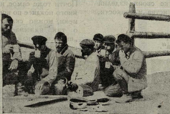
Завтрак рабочих-строителей на лесах.
