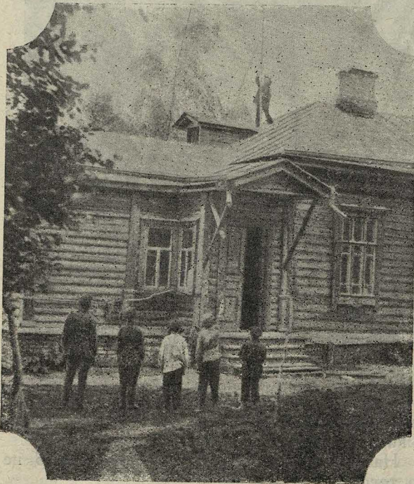
Установка антенны в деревне.
