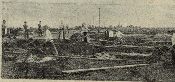
Тракт Орехово-Дубна. Работы по сооружению Земляного полотна, соединяющего Орехово-Зуево с Владимирским шоссе.
