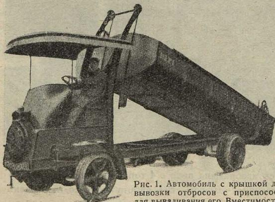
Рис. 1. Автомобиль с крышкой для вывозки отбросов с приспособл. для вываливания его. Вместимость 7 куб. метр. Грузоподъемность 7 тонн.
