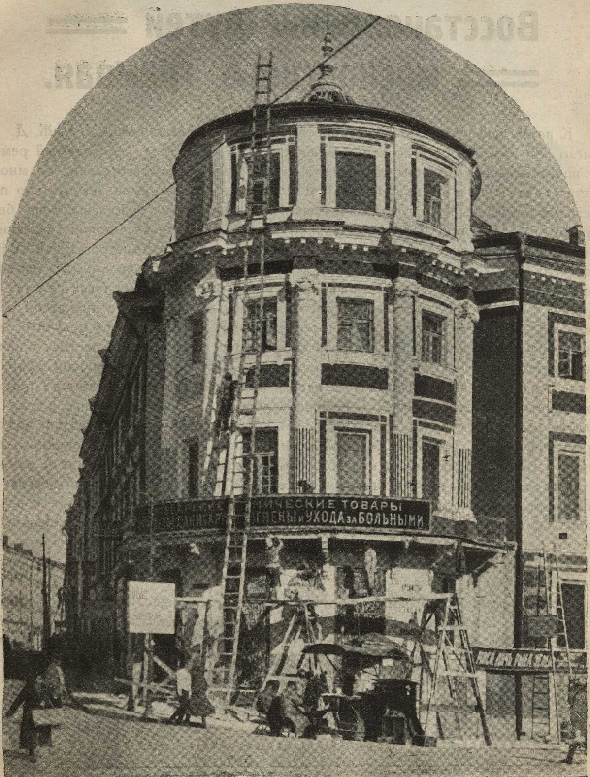
Ремонт дома № 2 на Маросейке.
