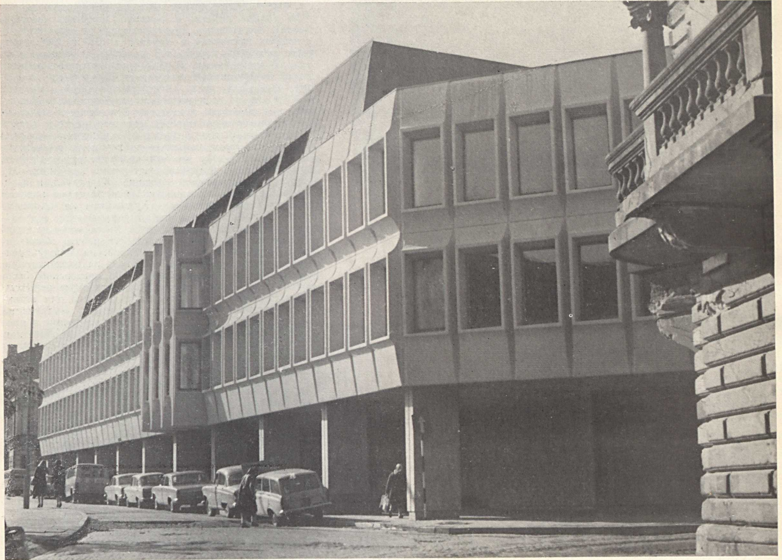
Архитектор Ю. Шейбокас Комплекс связи
