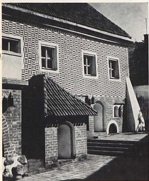
Дворик жилого дома по улице М. Горького. Вид после реконструкции.
