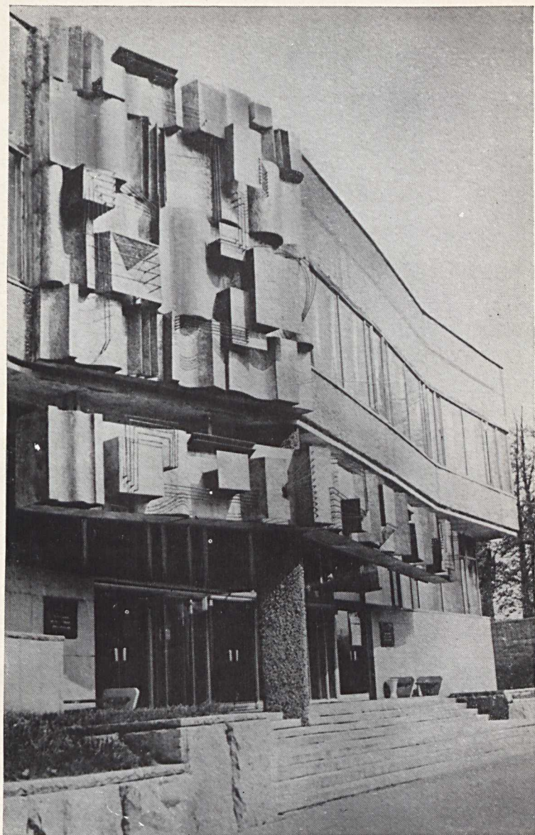
Рельеф из алюминия на здании НИИ типового строительства. Общий вид и фрагменты Москва. 1973
