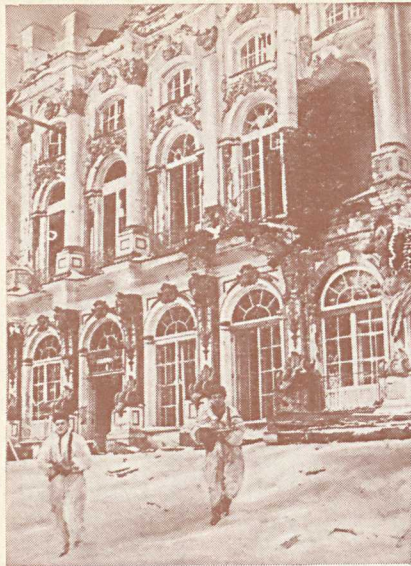
Пушкин. Разрушения Екатерининского дворца. 1944
