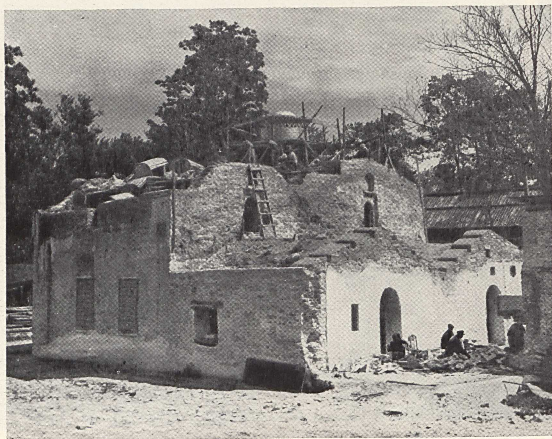
в процессе реставрации
