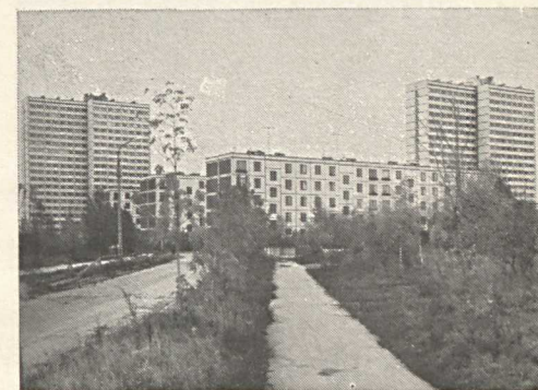
Сочетание пятиэтажной и башенной застройки на Ленинском проспекте
