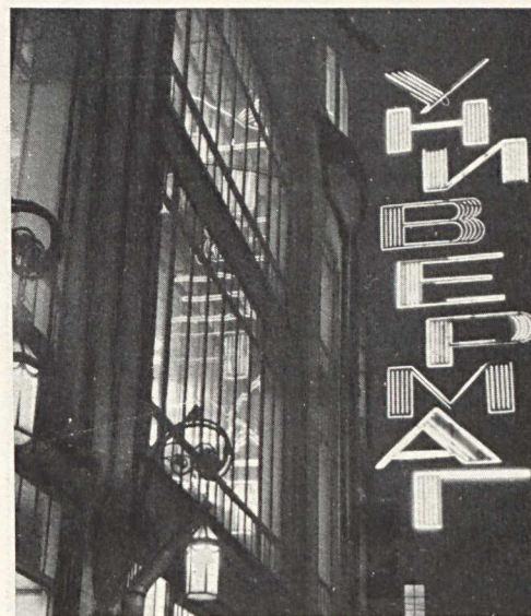
Надпись «Универмаг» не соответствует архитектуре здания.
