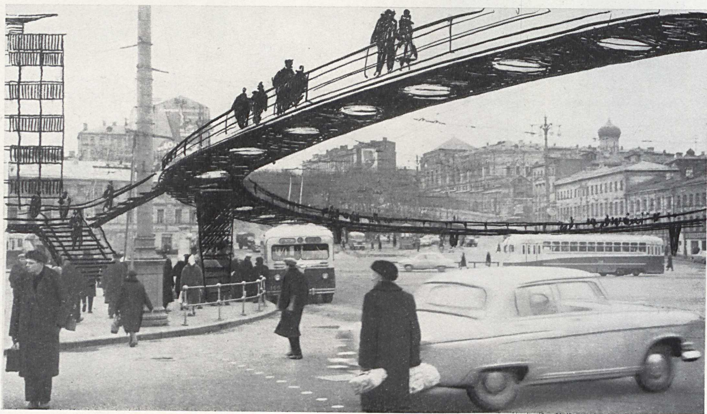
Проект пешеходного мостика, служащего навесом над остано- вками городского транспорта (рис. ав- тора статьи).
