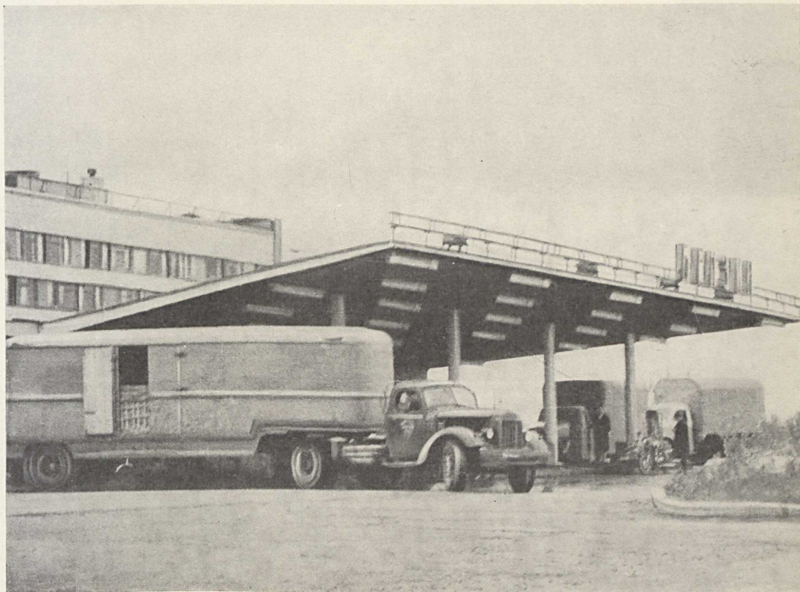
Ю. Раннинский, А. Шайхет, А. Суздальцева. Бензозаправочная станция.
