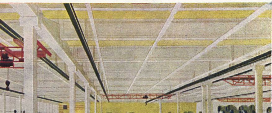
«Промстройпроект». Бесфонарное здание завода точного машиностроения с кондиционированным режимом.
