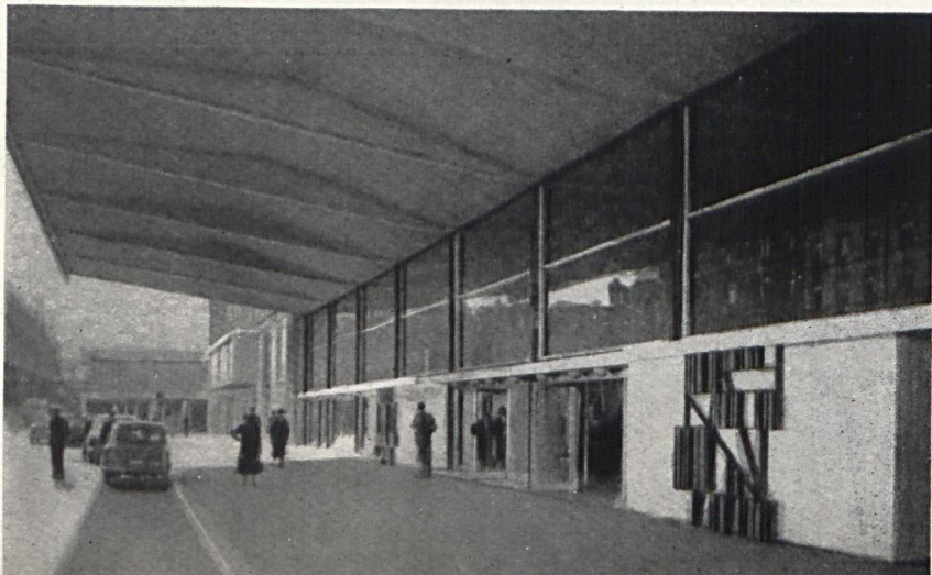
Крытый подъезд к железнодорожному вокзалу в Льеже, Бельгия.
