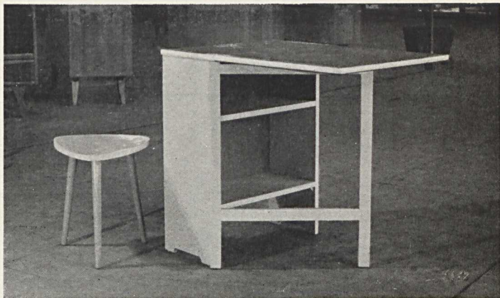
Кухонный стол. Отсутствие крепления ножки делает его неустойчивым. Выпускается фабрикой № 13. Москва.
