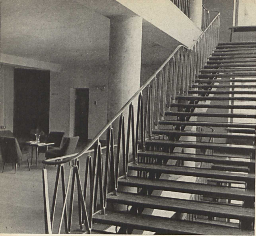
З. Розенталь, А. Бергельсон, К. Алексеев. Покрытие пола и лестницы из синтетических материалов. Холл в гостинице в Плотниковом пер. Москва.
