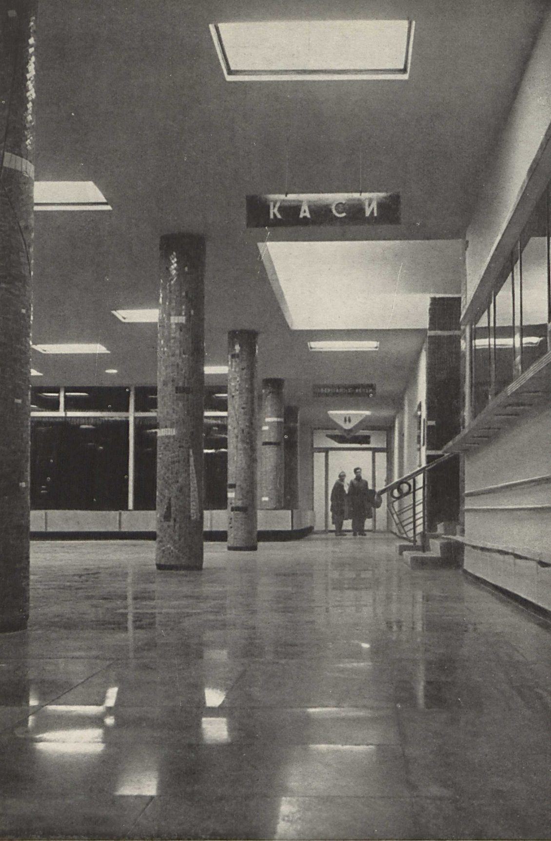
Автовокзал. Вестибюль, 1-й этаж.
