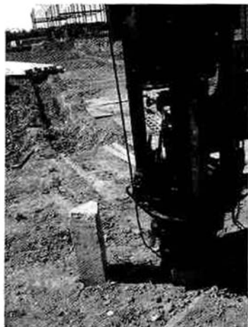
Рис. 3. Устройство свайного фундамента
