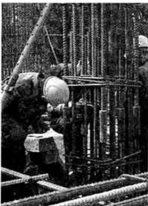
Рис. 3. Сварные соединения арматурного проката класса Ан600С
