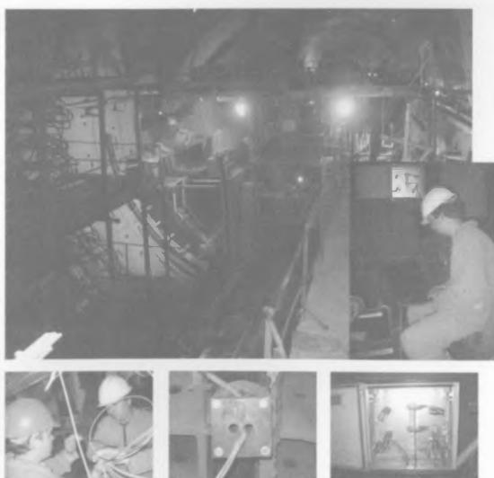
Мониторинг процесса создания и состояния ледогрунтовых
