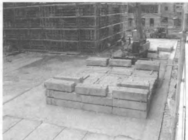
Рис. 3. Общий вид стройки с полной нагрузкой на испытываемый узел. Вид со стороны оси 5
