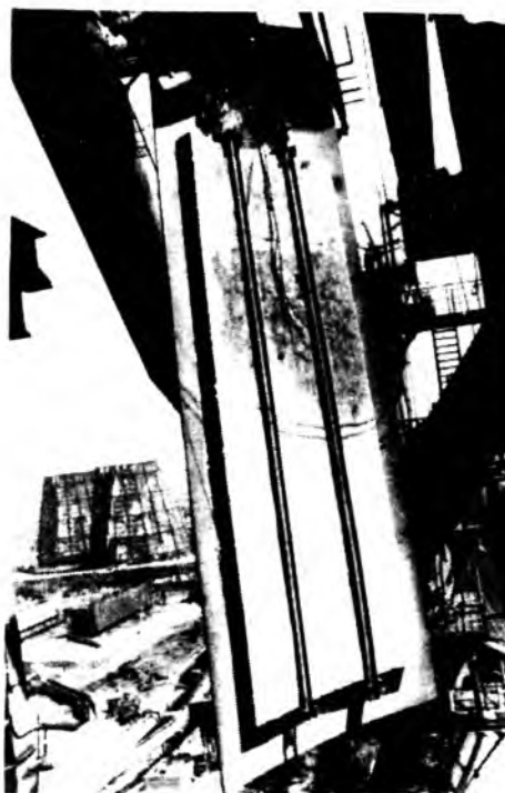
Рис. 2. Подъем укрупненного узла кожуха доменной печи в процессе монтажа
