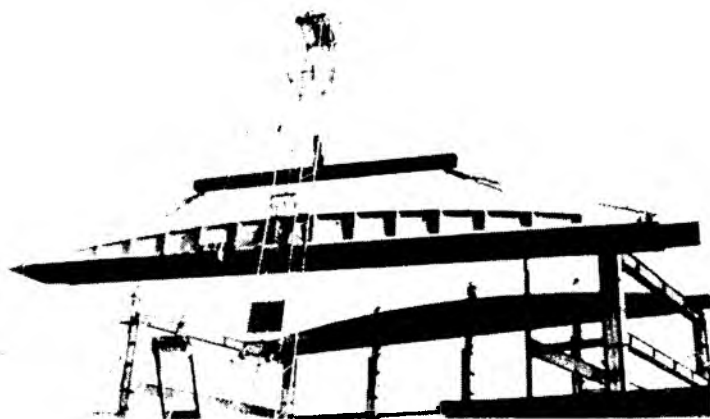
Монтаж панелей-оболочек КЖС
