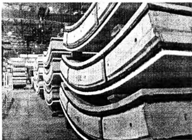
Рис. 1. Блоки обделки в цехе
