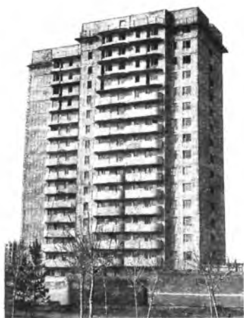
Рис. 1. 16-этажный дом в Павлодаре
