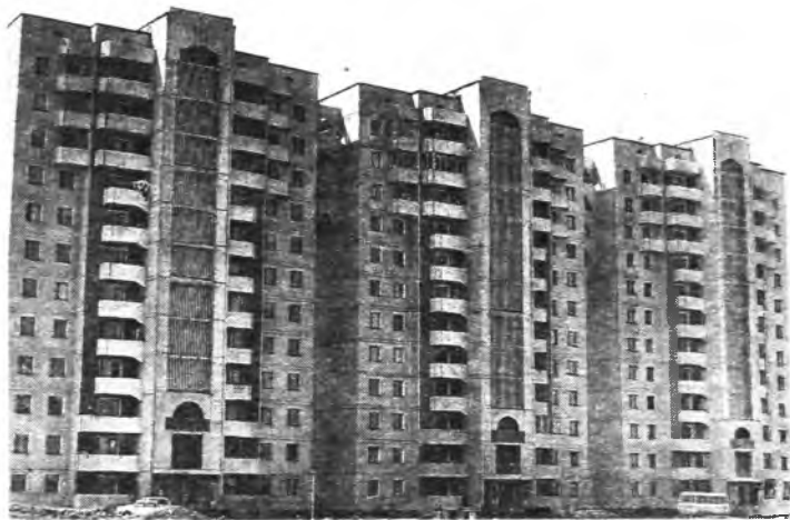
Рис. 2. 12-этажный жилой дом в микрорайоне Самал-2
