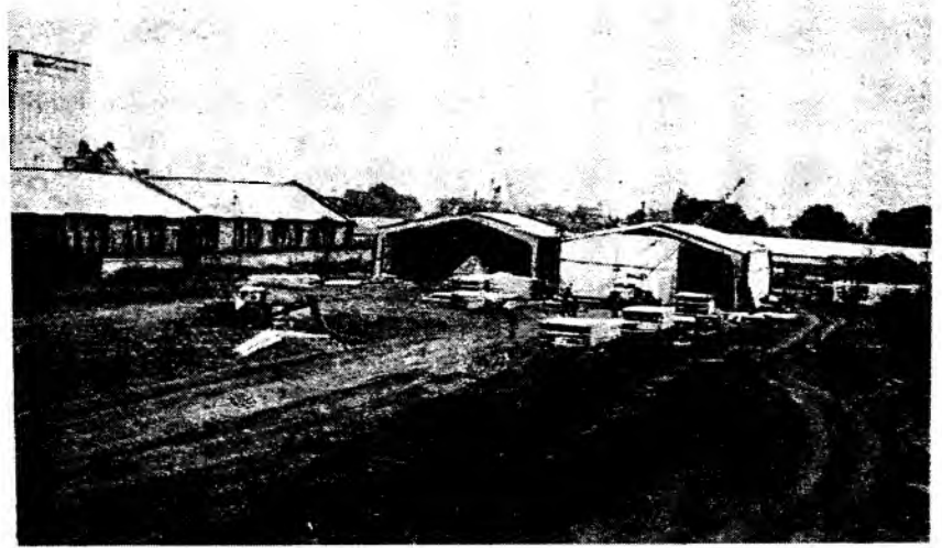
Рис. 2. Строительство фруктохранилища «Кавказ» вместимостью 5 тыс. т в Ставропольском крае
