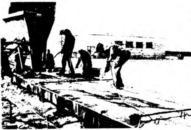
Рис. 1. Нанесение пленкообразующего состава ВПС на поверхность свежесформованных свай с применением окрасочного агрегата высокого давления 7000 НА
