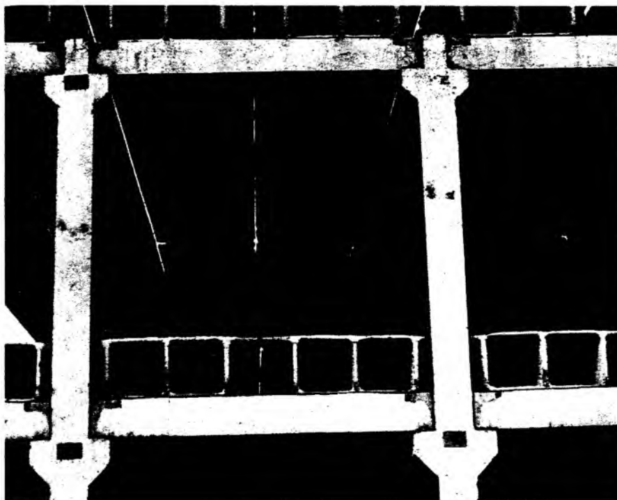
Коробчатый настил, армированный канатом К-19, примененный на строительстве Брестского тонкосуконного комбината
