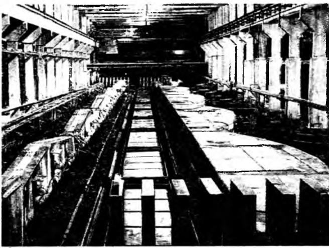
Рис. 1. Стендовая линия для изготовления ферм, плит покрытий и балок на Ереванском заводе ЖБИ № 5
