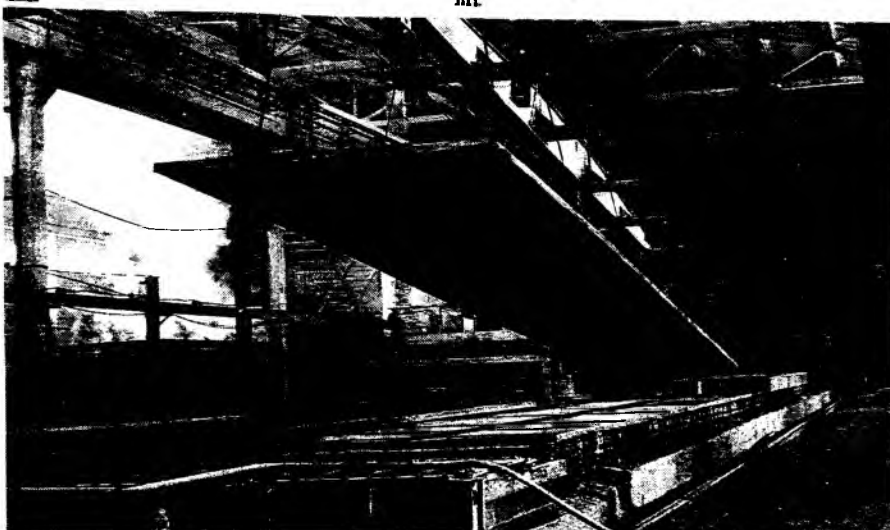
Рис. 2. Транспортирование железобетонной пластины размером 3 \times 18 м к месту сборки
