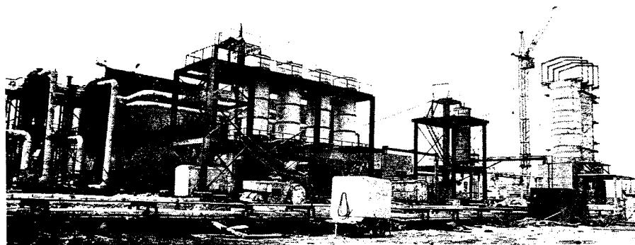
Установка для помола гранулированного доменного шлака
