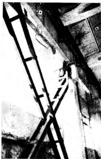
Рис. 2. Повреждение металлических связей
