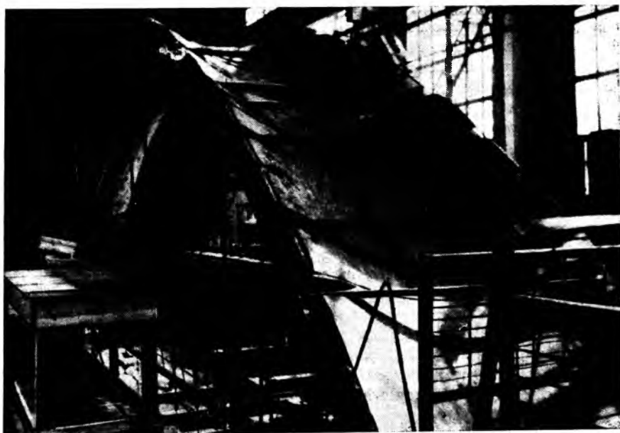
Рис. 1. Свод, подготовленный к испытаниям
