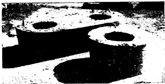
Рис. 1. Железобетонные свайные оголовники ОС-1 и ОС-2
