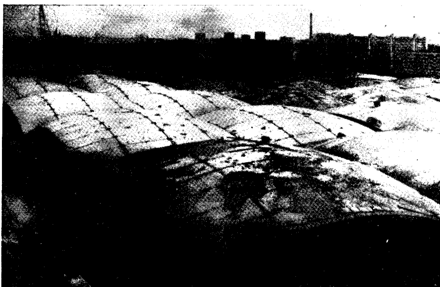
Рис. 2. Строительство автобусного парка
