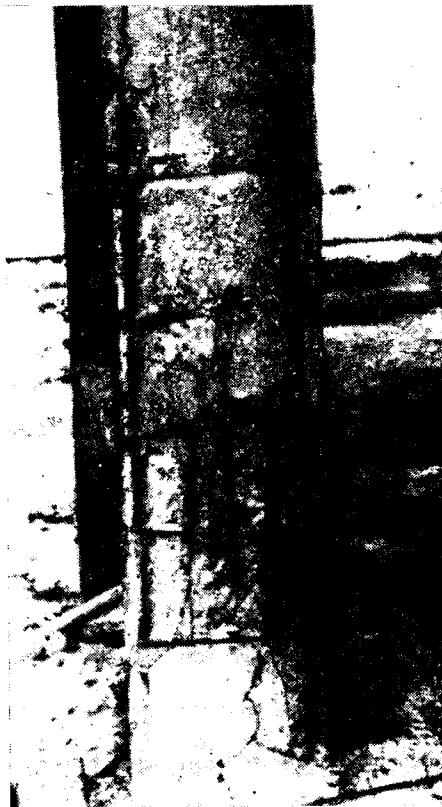
Рис. 1. Разрушения защитного слоя бетона эстакад от коррозии арматуры
