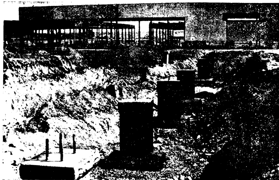
Рис. 2. Монтаж сборных фундаментов
