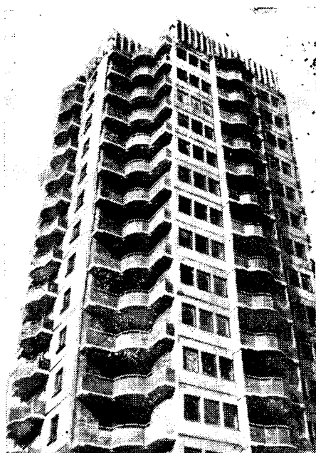
Рис. 2. 16-этажный 64-квартирный жилой дом на завершающем этапе строительства
