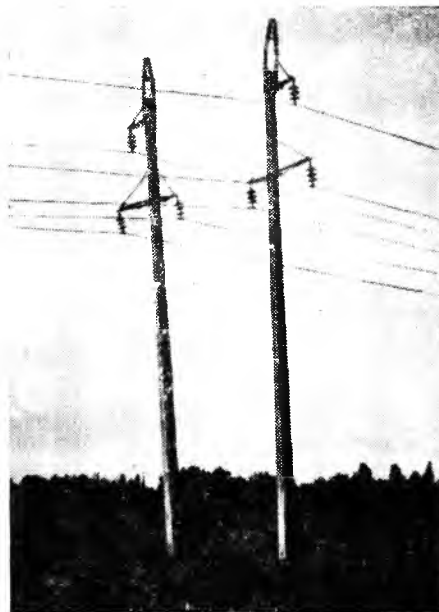
Рис. 2. Бесспиральные вибрированные опоры ЛЭП напряжением 35 кВ, установленные в районе Абаши от подстанции Суджуна (ГССР)
