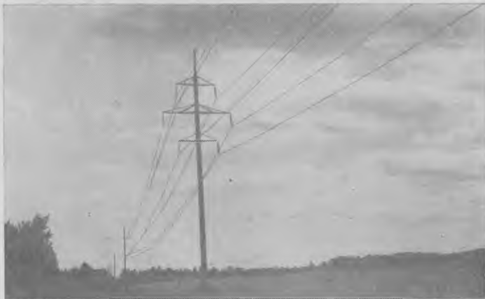
Рис. 1. Золошлакожелезобетонные центрифугированные опоры на линии 110 кВ Рославль — Ершицы (Смоленской обл.)
