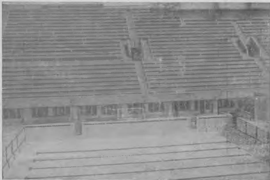
Рис. 3. Монолитное самонапряженное покрытие трибун и ванны плавательного бассейна в Лужниках
