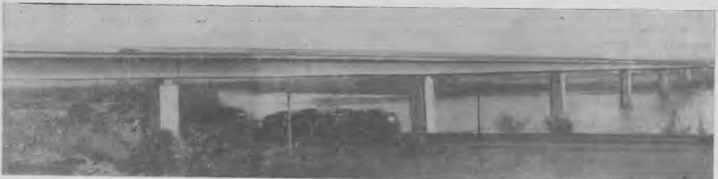
Рис. 4. Мост через р. Самару
