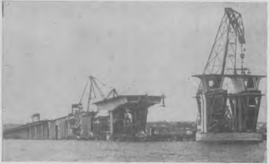
Рис. 2. Панорама строительства моста через р. Днепр
