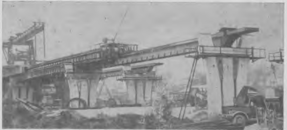
Рис. 3. Кран-перегрузчик и телескопический монтажный агрегат для попролетной сборки конструкций ПРК-ЦНИИС
