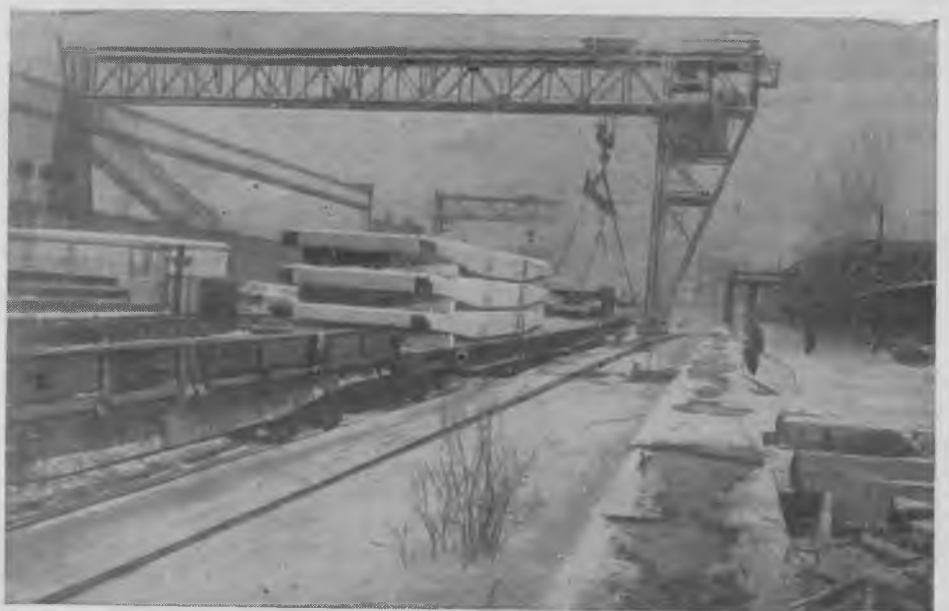
Рис. 4. Перевозка плит железнодорожным транспортом
