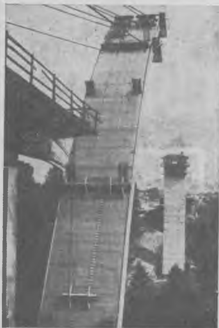
Рис. 1. Бетонирование арки моста
