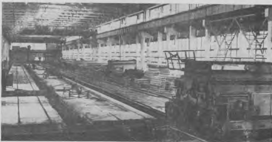
Рис. 1. Цех безопалубочного формирования Северского завода ЖБИ
