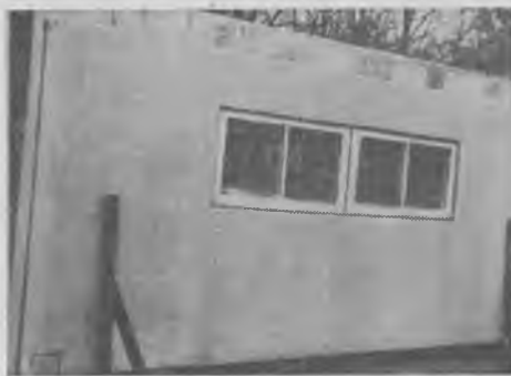
Укрупненная стеновая панель из полистиролбетона
