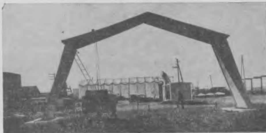
Рис. 2. Складчатая тонкостенная рама из сталефибробетона
