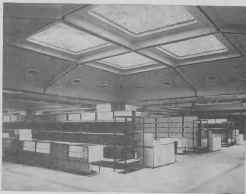
Сборные шатровые перекрытия 12×12 м торгового центра в Омске, возведенные Минтяжстроем СССР
