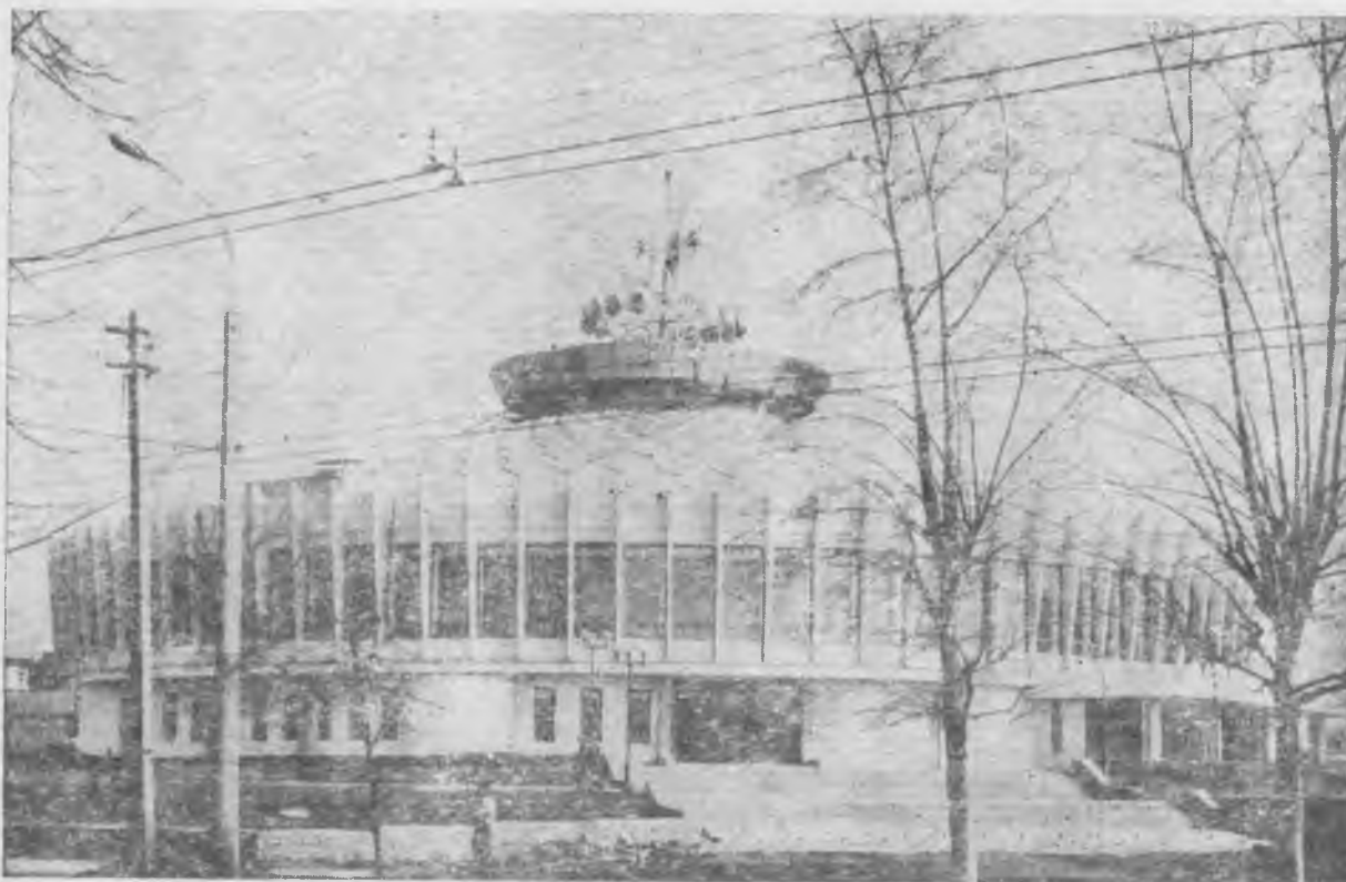
Цирк в Костроме. Купол — сборно-монолитный диаметром 43 м. Монтировали без лесов навесным способом
