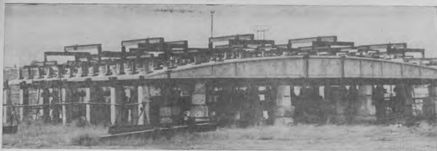
Рис. 1. Испытание покрытия из панелей-оболочек КЖС с балками подвесных крановых путей
