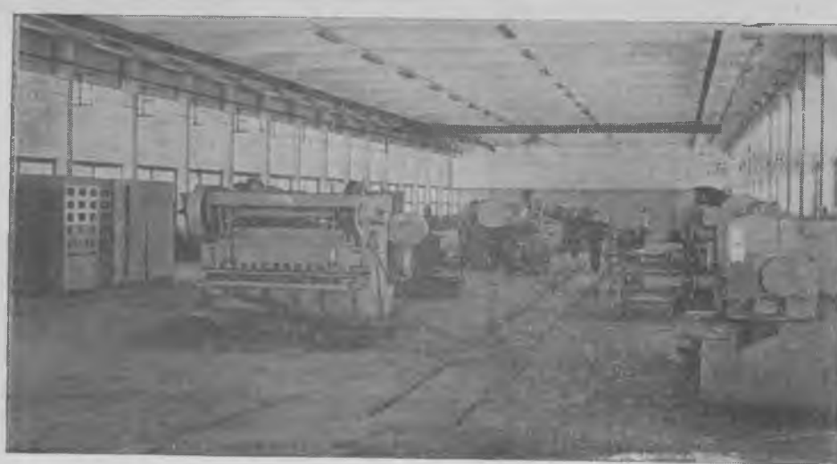
Рис. 5. Интерьер промышленного здания с покрытием из панелей-оболочек КЖС, несущих подвесной кран
